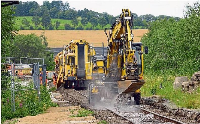
Mit großem Maschineneinsatz werden auf der Eifelstrecke mehr als neun Kilometer Gleise erneuert.
