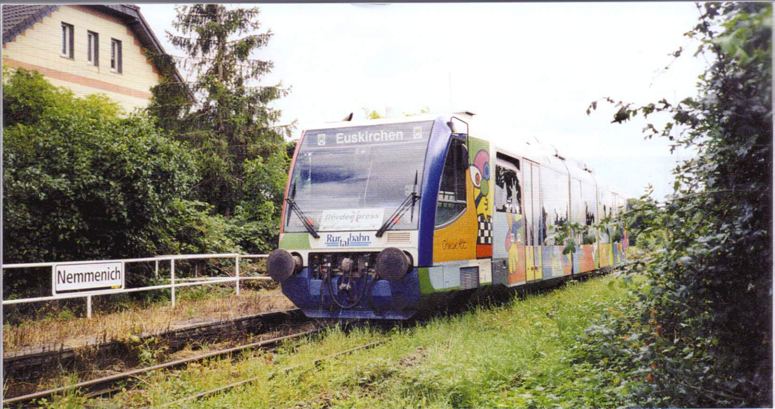
Hier gab es für die Bürgerbahner vom Bördeexpress vor der Landesgartenschau einiges zu tun: Der heruntergekommene Haltepunkt Nemmenich war von der DB Netz AG geschlossen worden.
